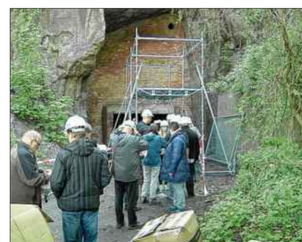
Die Konstruktion wurde Sonntag wieder abgebaut. Nun wird eine dauerhafte Lösung angestrebt. MT-Foto: jhr
