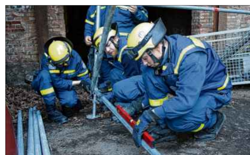
Da immer wieder Steine im Eingangsbereich abrutschen, musste zum Schutz der Besucher ein Portal aufgebaut werden. Foto: pr
