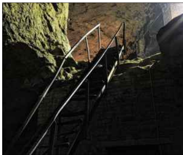
Eine durch die Sprengung teilweise zerstörte und verbogene Treppe. MT-Fotos (2): Alex Lehn
